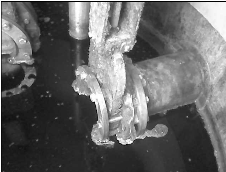
Abb.: Korrodiertes Bauteil
