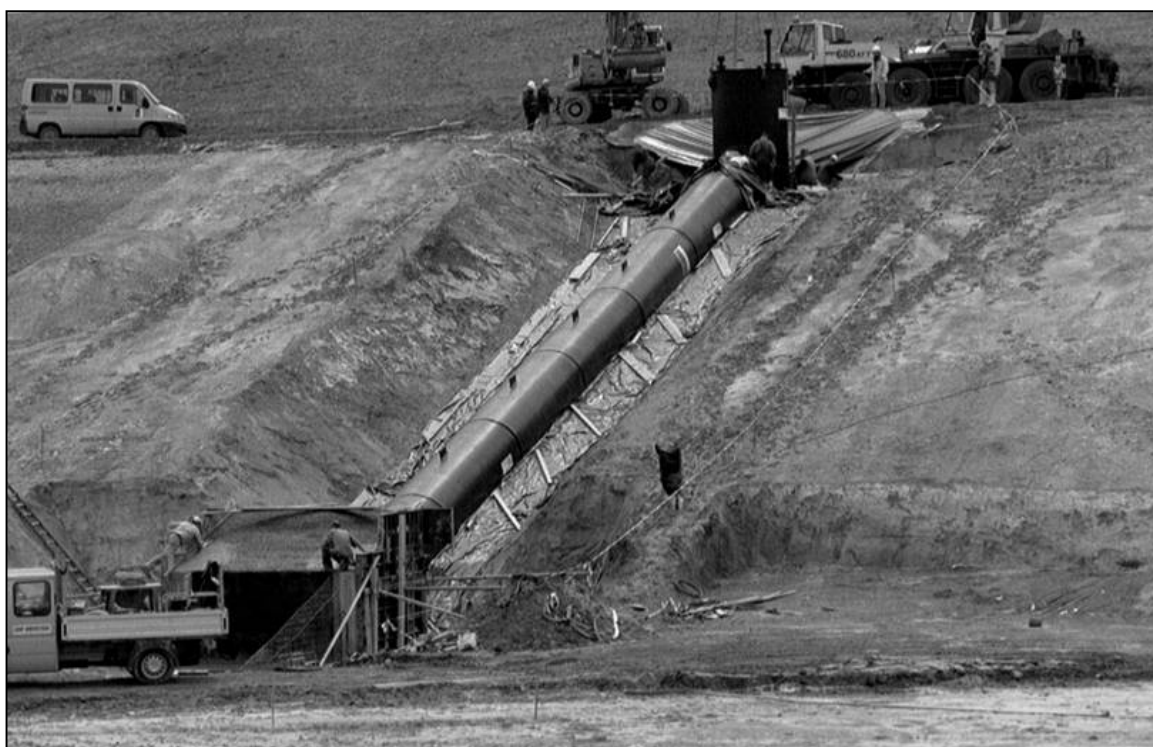
Abb.: Kunststoffschrägschacht
