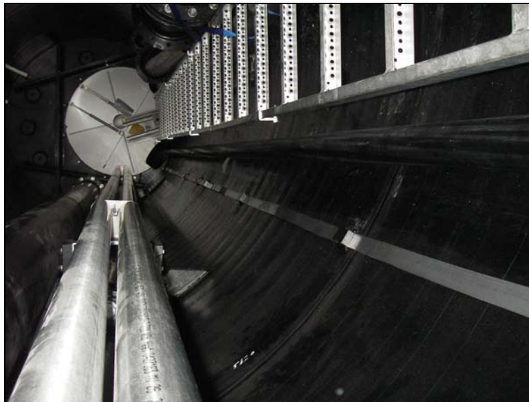
Abb. 22: Schacht mit elektrisch leitfähiger Innenfläche und Potentialausgleichsschiene
