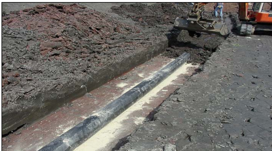
Bild 4: Beispiel Rohraufleger bei offener Verlegung
