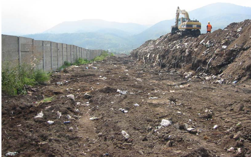
Foto 5: Randbereichsprofilierung an der Südwestböschung
