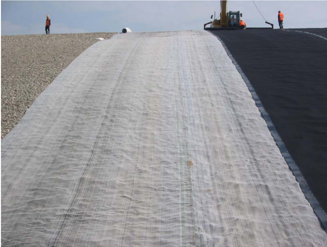
Foto 8: Verlegung der Bentonitmatten und der KDB auf der Südwestböschung
