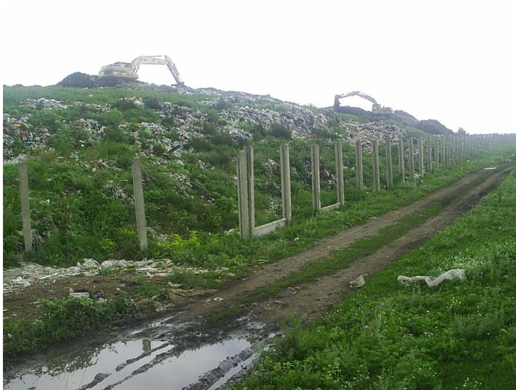
Foto 4: Müllumlagerung auf der Südwestböschung
