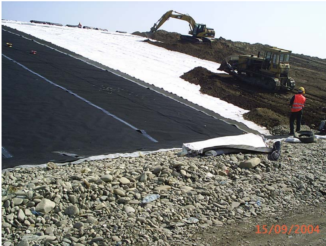
Foto 10: Rekultivierungsbodenauftrag auf der Südwestböschung
