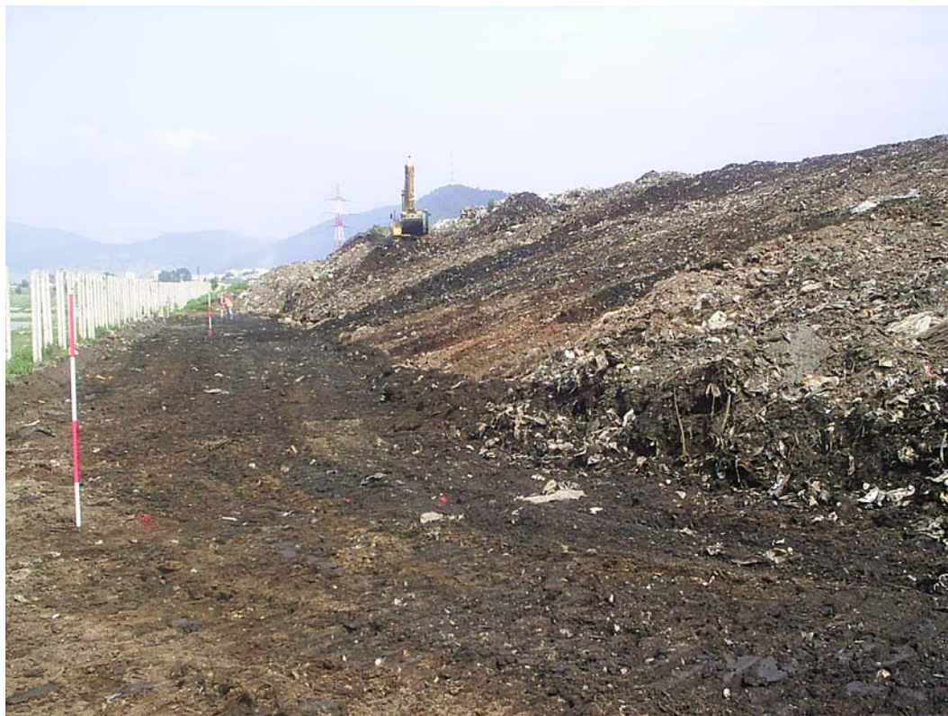
Foto 6: Profilerungsarbeiten auf der Südwestböschung
