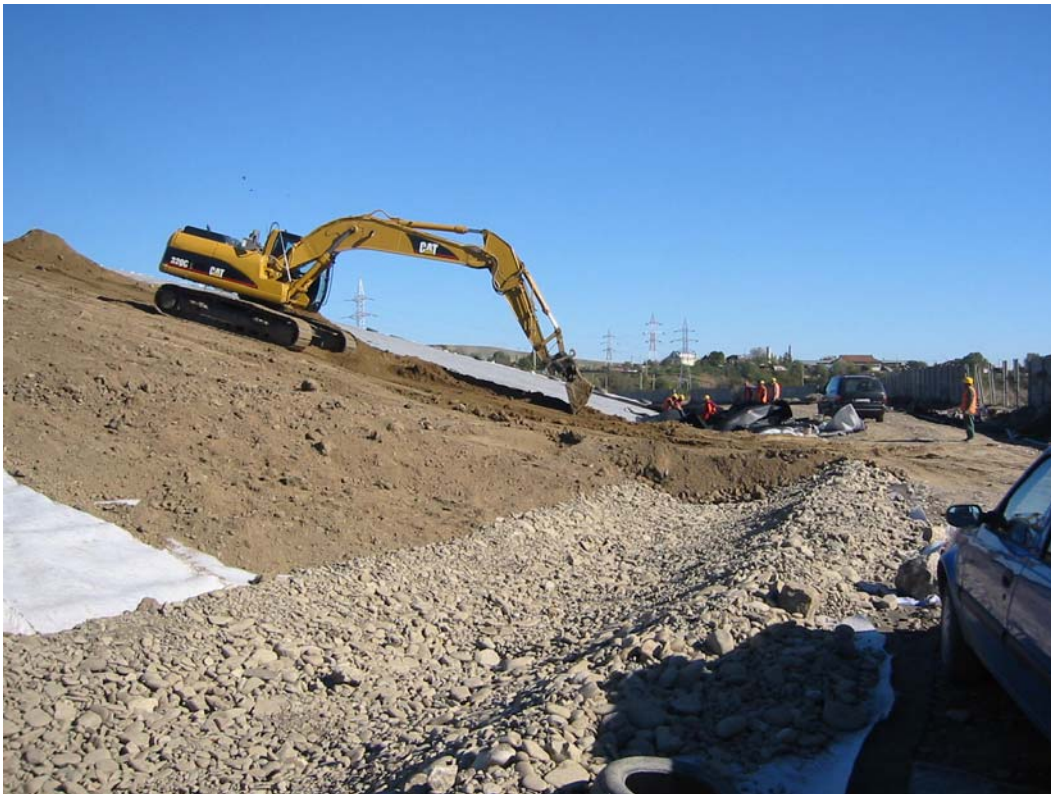
Foto 9: Einbau des Rekultivierungsbodens und Ausbau des Randgrabens auf der Südwestböschung
