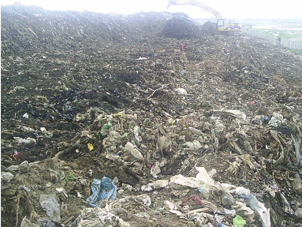
Foto 3: Müllumlagerung auf der Südwestböschung der alten Deponie im Sommer 2004
