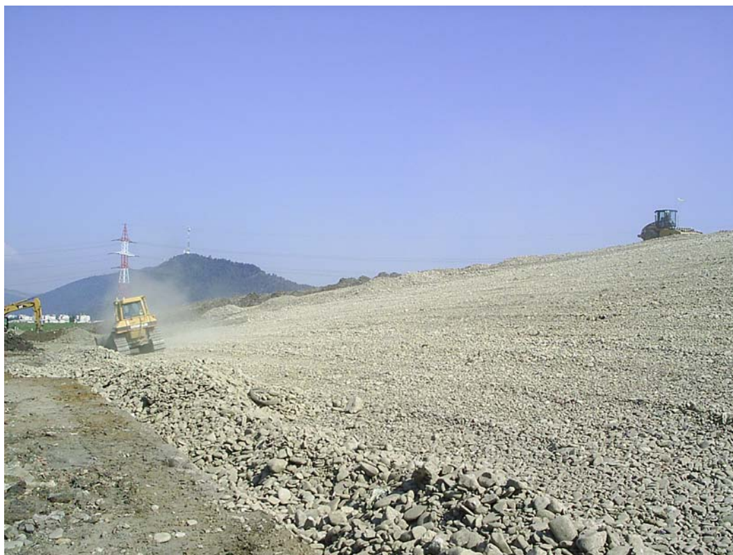
Foto 7: Einbau der Ausgleichsschicht auf der Südwestböschung
