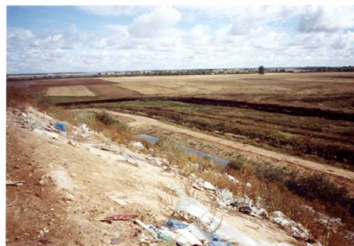
Neuer Meliorationsgraben, der den Zustrom von Niederschlags- und Drainagewasser zur Deponie verringert
